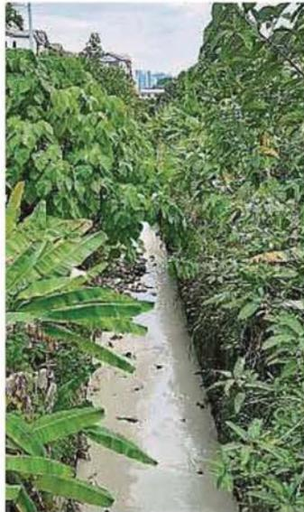
翠岭镇大路旁沟渠长满树木野草,长年没有清理,树根已破坏沟壁。
